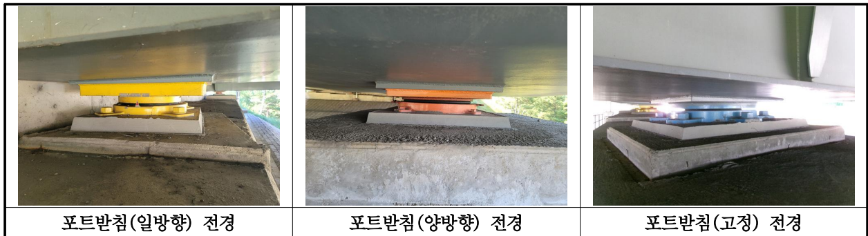
【사진 1.3.12】 교량받침 전경
