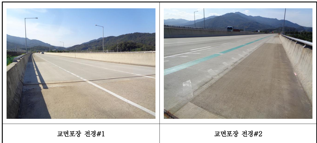
【사진 1.3.19】 교면포장 전경
