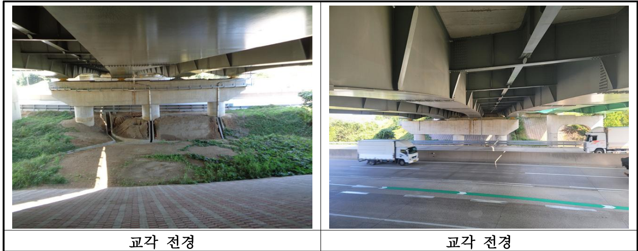
【사진 1.3.10】 교각 전경
