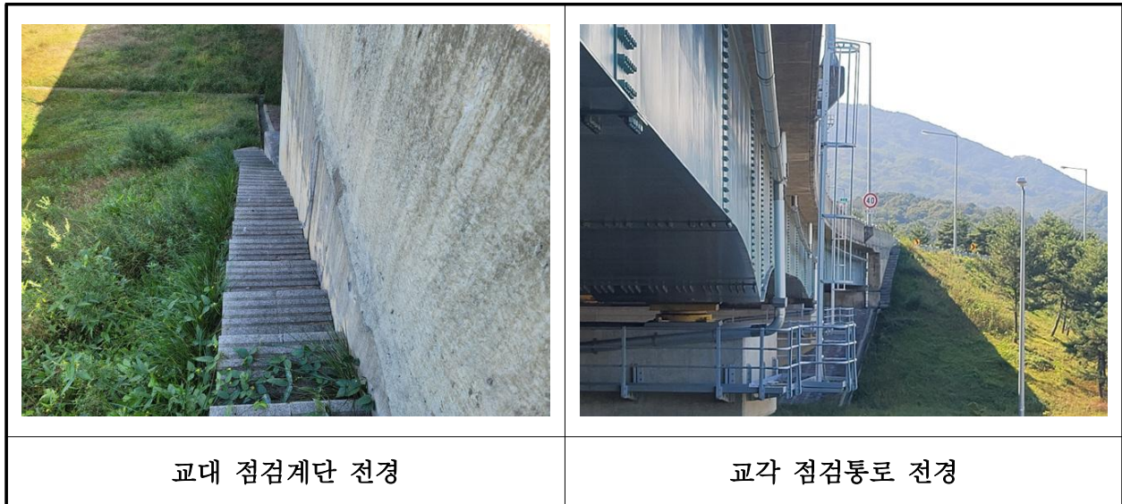
【사진 1.3.25】 교량 점검시설 전경
