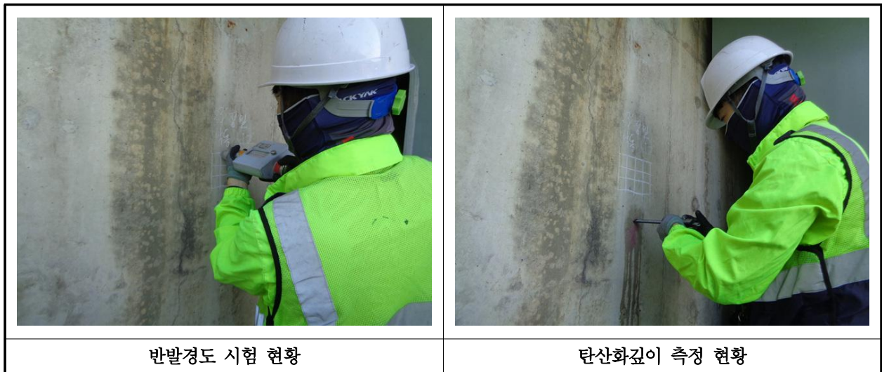
【사진 1.4.1】 콘크리트 내구성조사 현황
