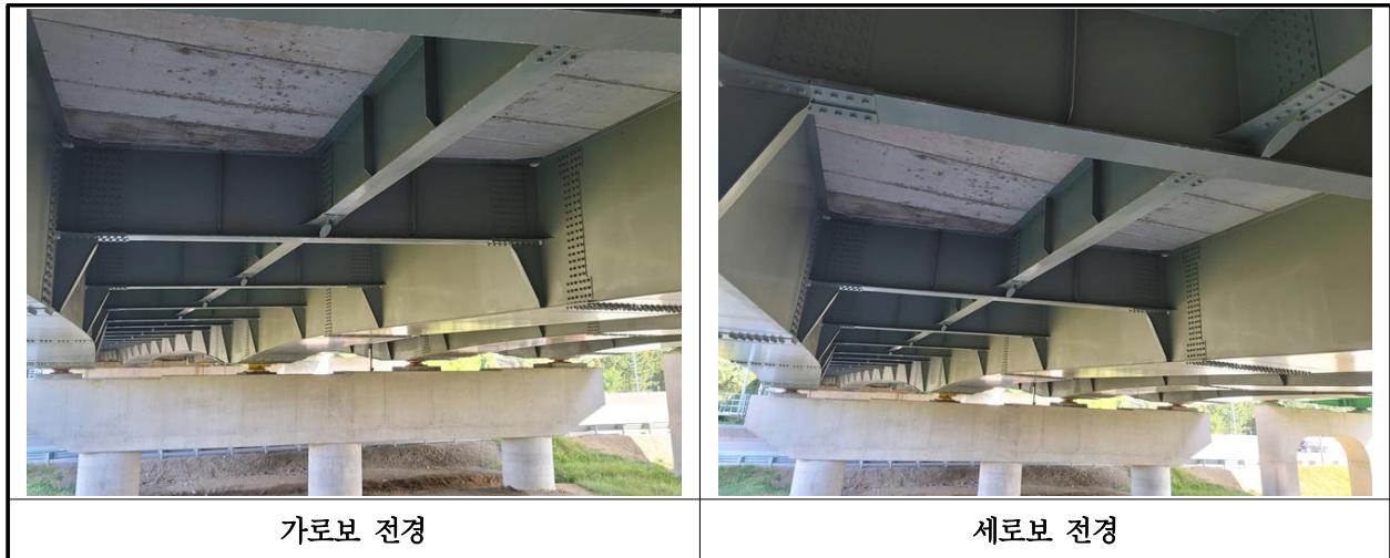
【사진 1.3.6】 가로보 및 세로보 전경
