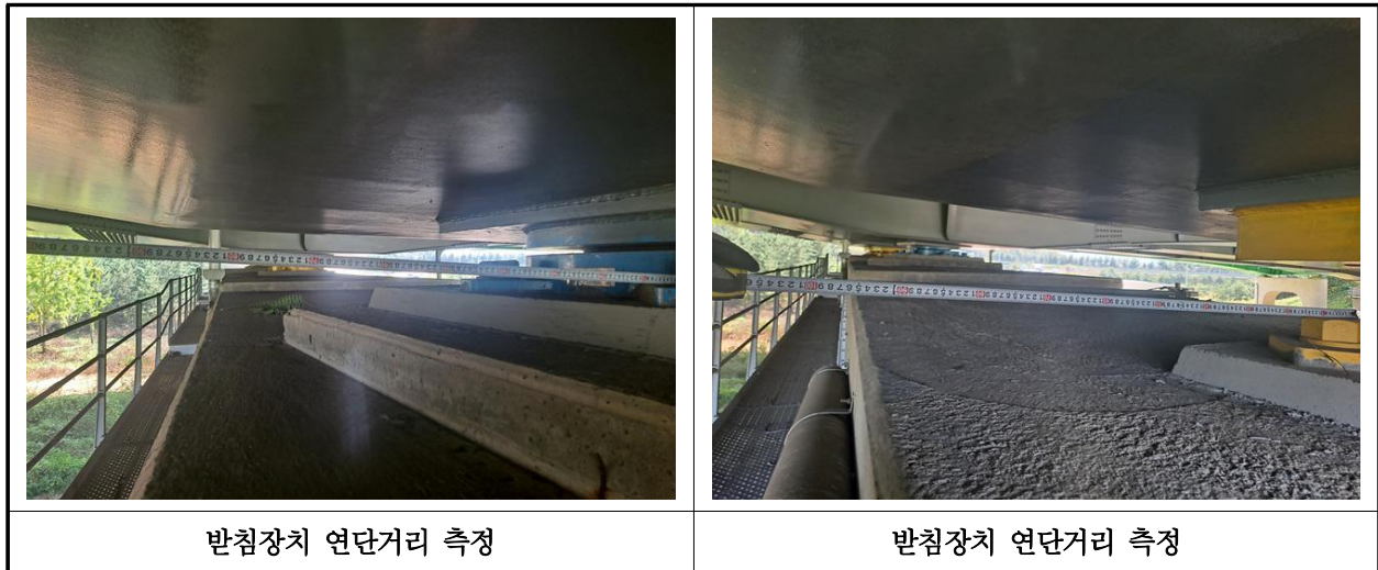
【사진 1.3.14】 교량반침장치 연단거리측정
