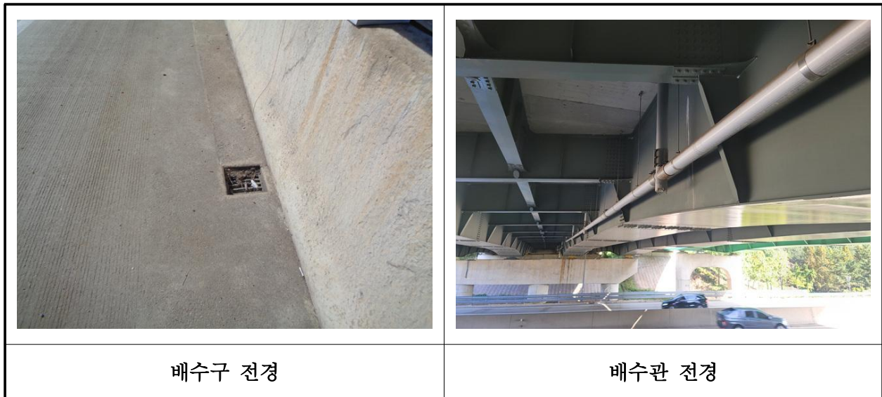
【사진 1.3.21】 배수시설 전경
