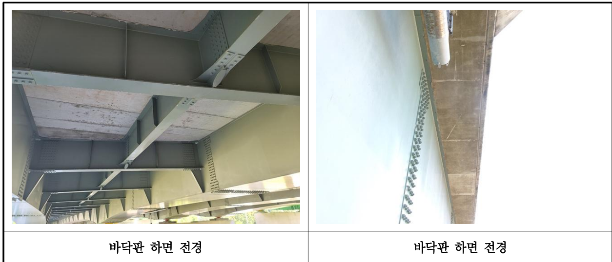
【사진 1.3.2】 바닥판하면 전경
