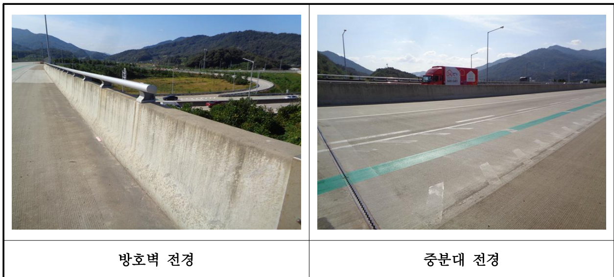
【사진 1.3.23】 방호벽 및 중앙분리대 전경
